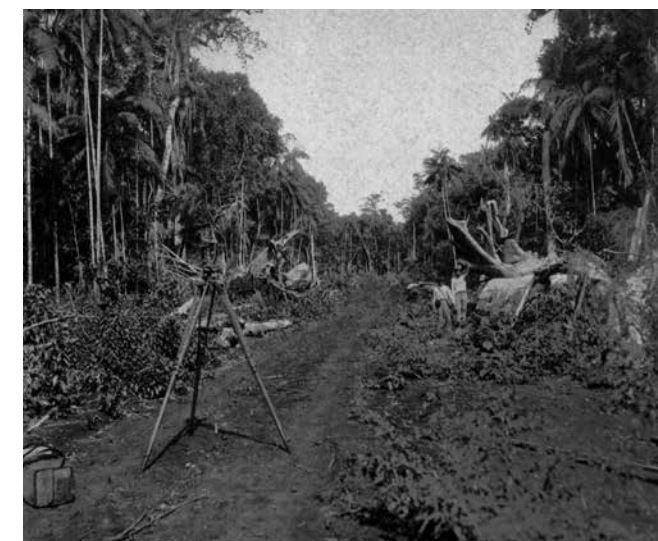
Na floresta primitiva, a abertura de estrada é “guiada” pelo teodolito, o “medidor” óptico de alta precisão. Foto: autor desconhecido/acervo MHL Padre Carlos Weiss
