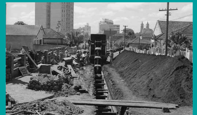
Obras de saneamento na Rua Tupi – abertura de valetas para rede de esgoto, década de 1950. Autor Oswaldo Leite/Acervo Museu Histórico de Londrina Padre Carlos Weiss-UEL
