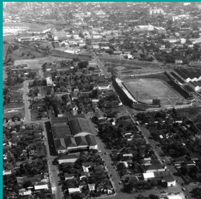
À esquerda do Estádio Vitorino Gonçalves Dias, a Vila Matos (zona do meretrício), área desapropriada na administração Antônio Belinati (1977-82) para dar lugar à estação rodoviária projetada por Oscar Niemeyer. Autor: Oswaldo Leite/Acervo Museu Histórico de Londrina Padre Carlos Weiss-UEL
