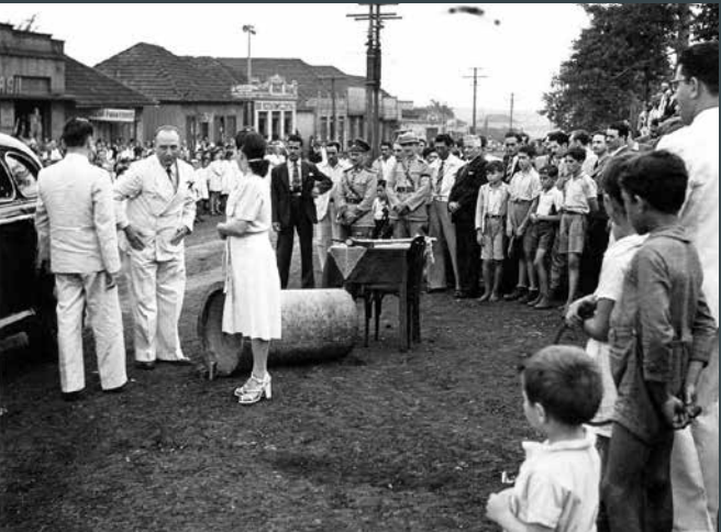
Início solene das obras de pavimentação, com o prefeito Miguel Balbino Blasi, na Avenida Paraná. Autor Carlos Stenders/Acervo Câmara Clara
